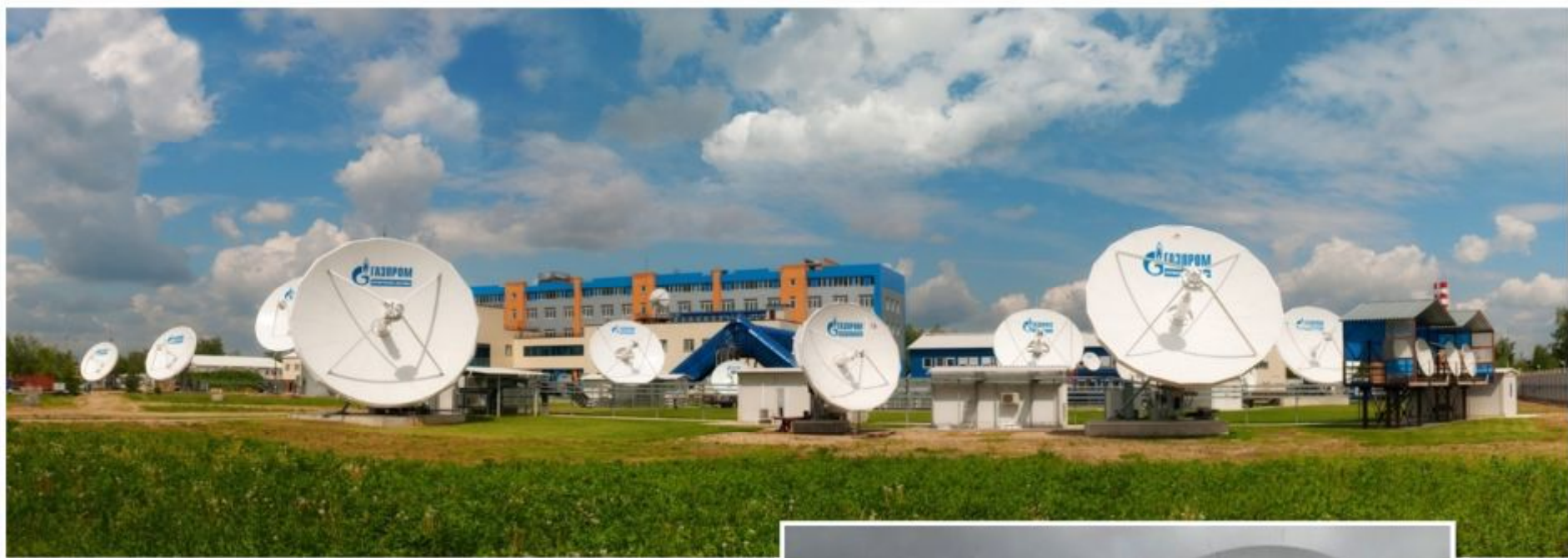
Телекоммуникационный центр (Щелково, Московская область)
